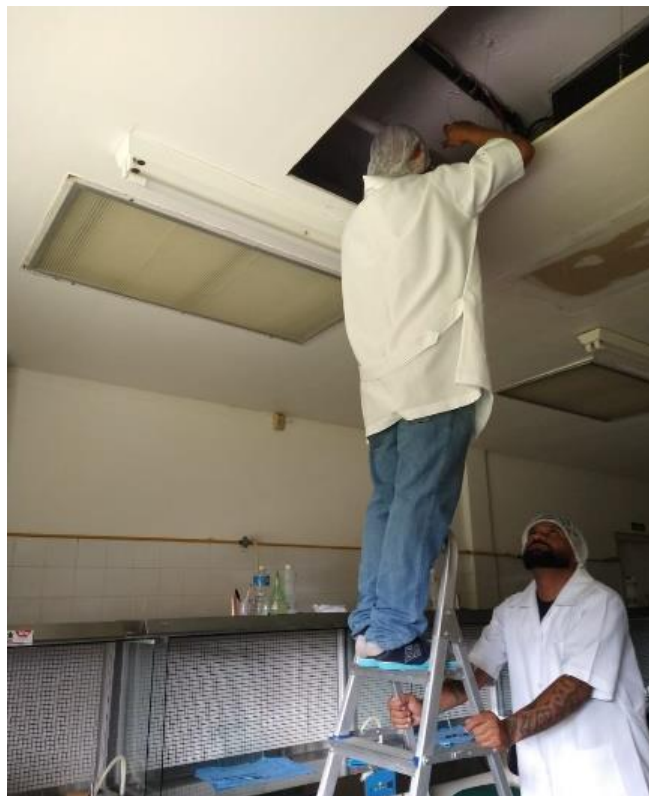
Manutenção no Sistema de Resfriamento do Laboratório
