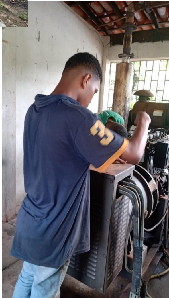
Serviço de Rebobinagem e Pintura do Gerador
